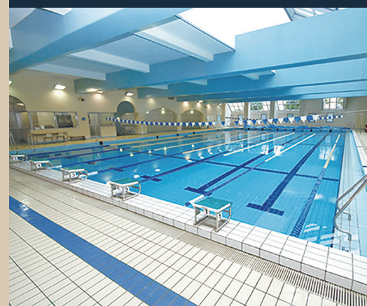
プール ソーラー式温水器付きで水温を調節。開放的な空間で快適に水泳を学べます。
